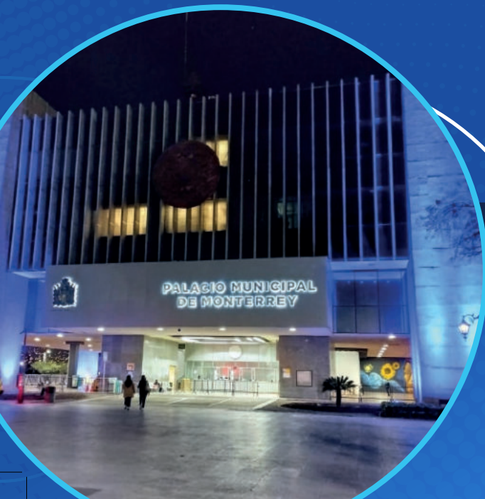
Iluminación de las oficinas de gobierno del municipio de Monterrey.
